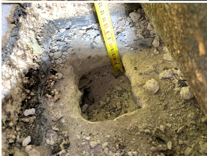
Cementový poter hr. 50 mm
