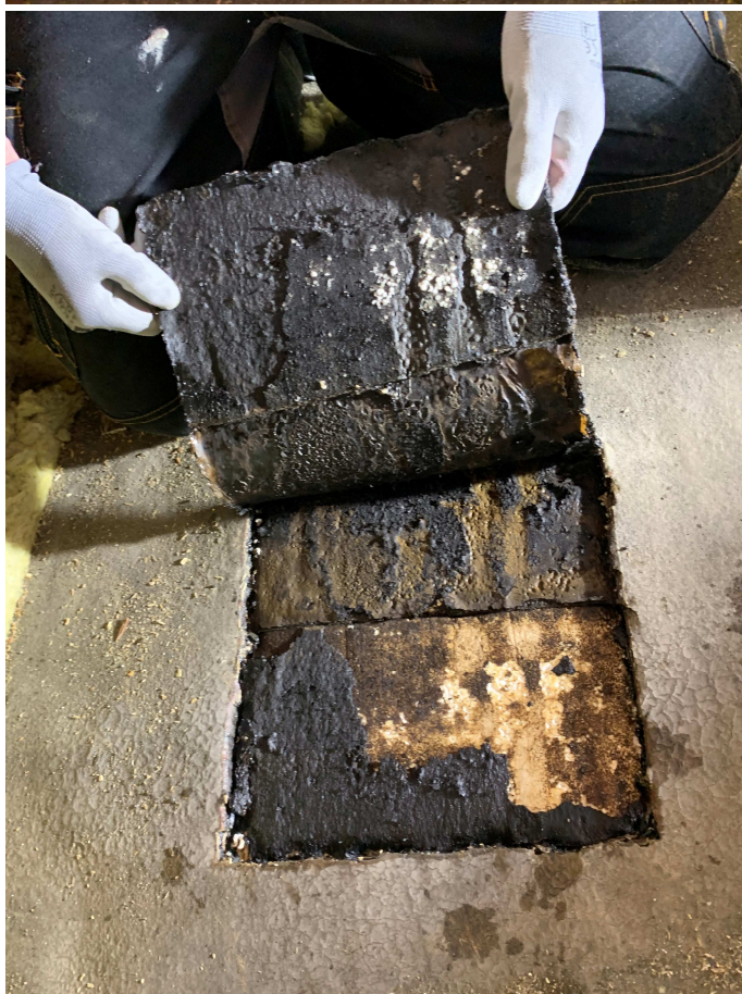
Povlaková krytina na báze asfaltovaných pásov hr. 13 mm
